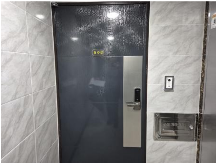
일련번호(나) 출입구 전경
